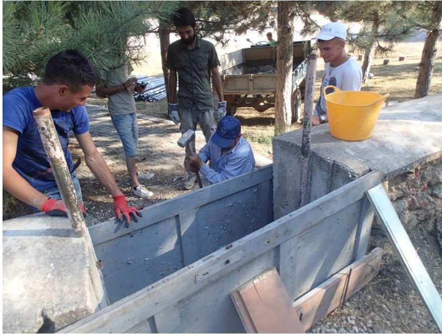
Resim 15: Kanlıtaş Höyük Kazı Evi (Aşağı Kuzfındık İlköğretim İlkokulu , İnönü/Eskişehir) Çevre Duvar İnşaatı
