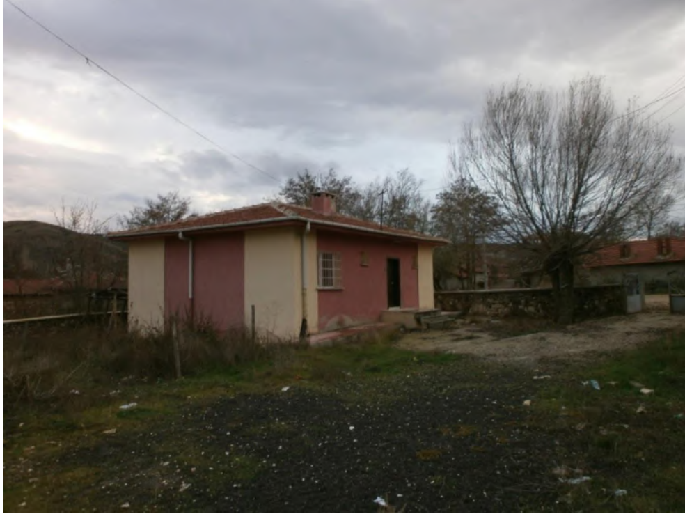
Resim 5: Kanlıtaş Höyük Kazı Evi (Aşağı Kuzfındık İlköğretim İlkokulu , İnönü/Eskişehir) Lojman Yapısı
