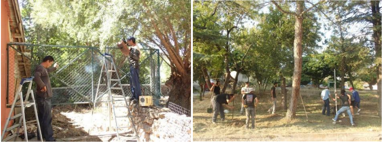
Resim 13-14: Kanlıtaş Höyük Kazı Evi (Aşağı Kuzfındık İlköğretim İlkokulu , İnönü/Eskişehir) Çit Panel Çevre Duvarı İnşaatı Ankrajlı Direk Çevirme Çalışmaları
