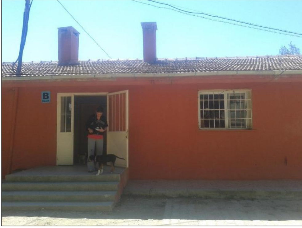
Resim 10: B Blok İlköğretim bina Giriş kısmından
