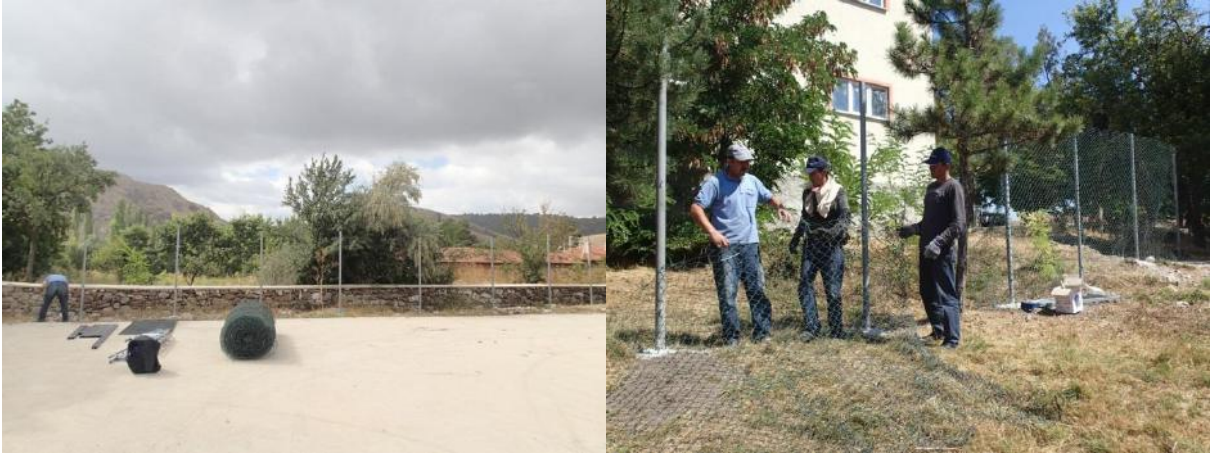
Resim 11-12: Ankrajlı Direklerin Tel ile Çevirme Çalışmaları
