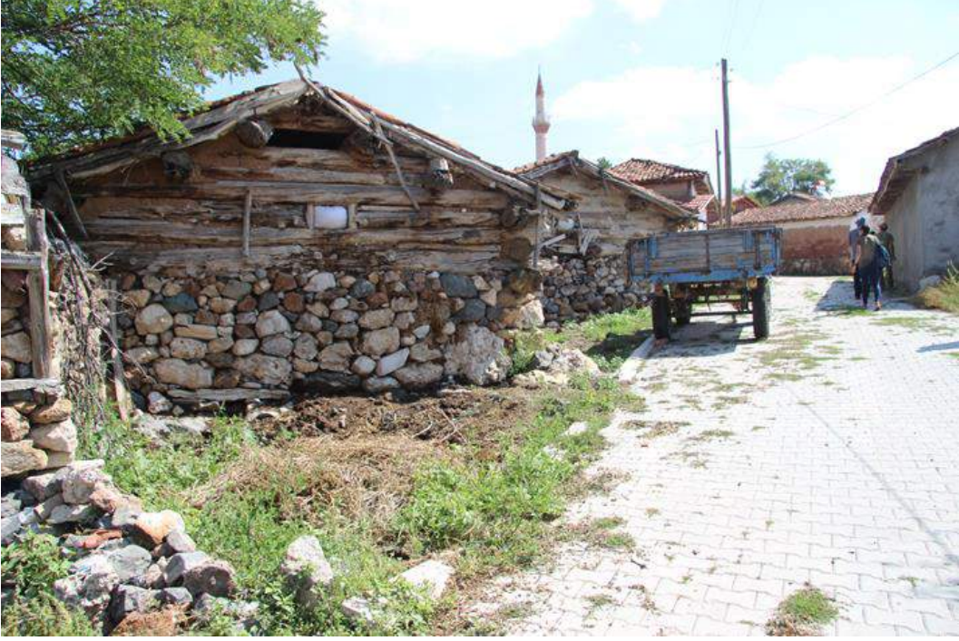
Resim 2: Esnemez Altı kuru duvar temelden üstü ahşap (Çam) birbirine geçme Ahır yapıları
