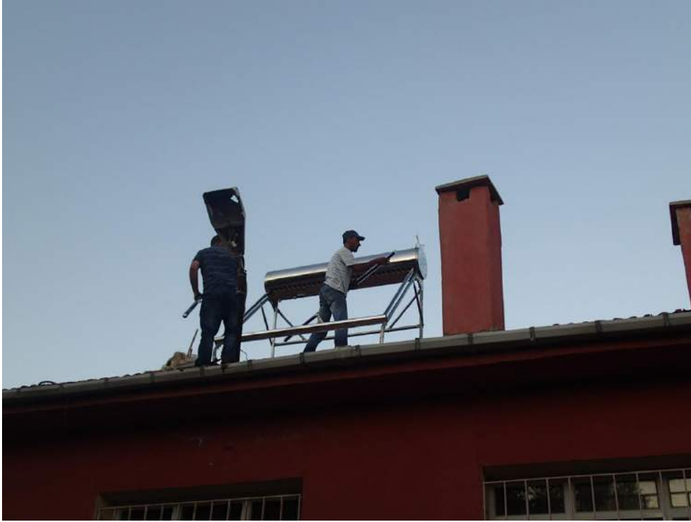
Resim 8 : Güneş Enerjili Su Isıtma Tesisatının Kurulması
