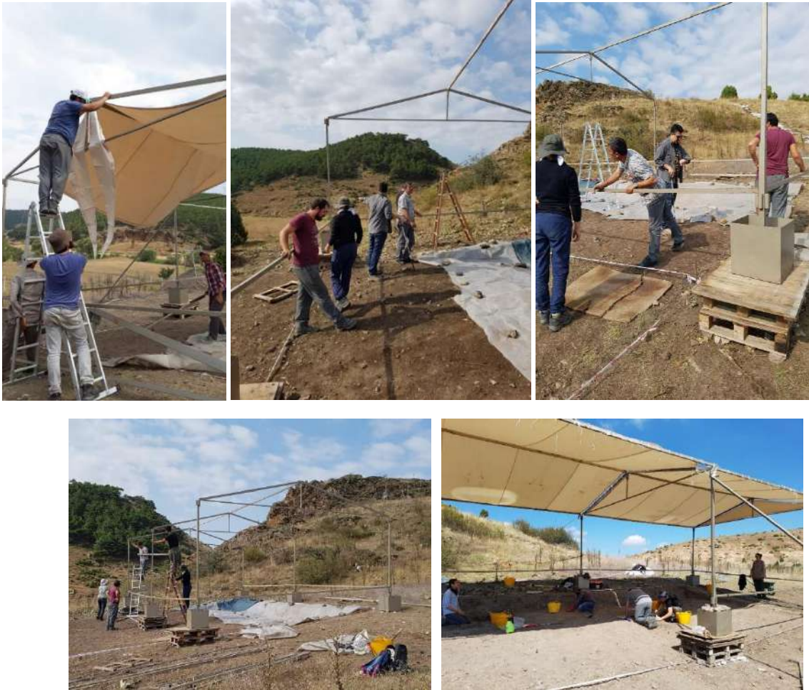
Şekil 1: Kazı alanına V çatılı üst örtü sisteminin kurulumu
